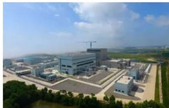
Site du démonstrateur HTR [photo:CNNC]
