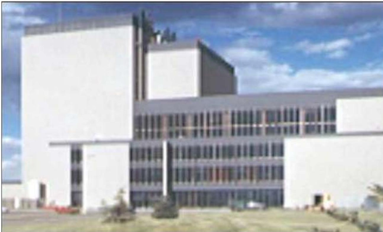
Réacteur prototype HTR de 300 Mwe refroidi hélium
